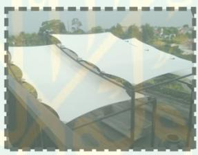
Struktur membran/tenda atap datar menggunakan struktur tenda yang memikul beban dengan menggunakan tegangan tarik/tensile. Bahan membrane yang dipakai adalah serat PVC coated Polyester dengan lapisan top coated PVDF
